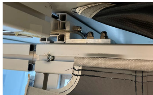
*8 - De två takstolarna ska nu fästas på frontväggens överliggare genom att lägga i en T-skruv och sedan fästa i tredje B-vinkeln från respektive kant.
