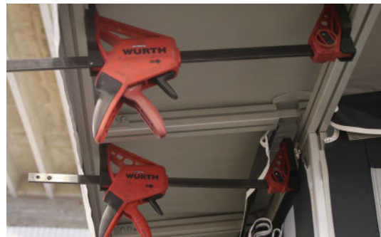
*8 - Spänn upp taket på utsidan vid frontväggen med hjälp av två tvingar.
