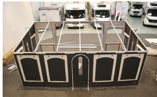
*7 - De två takstolarna nr 8 fästs i bakväggens överliggare på den tredje C-vinkeln ifrån kanten på respektive sida.
