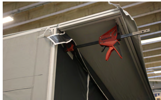
*7 - Spänn upp yttertaket på utsidan genom att tvinga ut de yttre takstolarna både vid front- och bakväggen.
