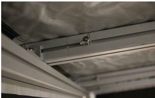
*3 - Gö in i tältet och löst skruva fast T-skruv i mutterbrickorna.
