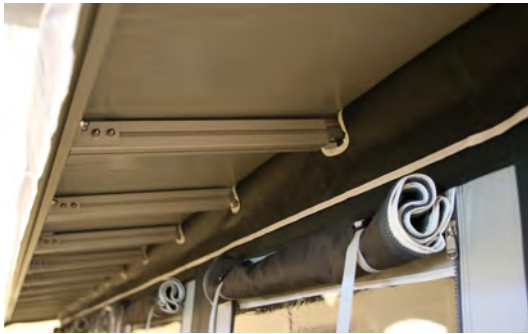
*1 - Justera takstolar och B-vinklarna på frontväggens överliggare efter avsedda hål i taket.
